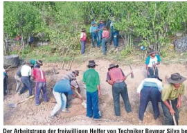
Der Arbeitstrup der freiwilligen Helfer von Techniker Beyerma Silva bei Grabungsarbeiten im steinigen Gelände.
